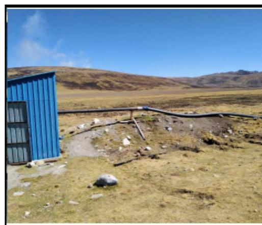
**FOTOGRAFIA N° 10 y 11** En las imágenes se aprecia la electrobomba y la manguera HDPE de 6" de diámetro que conduce el agua a la Planta Concentradora María Mercedes S.A.C.
