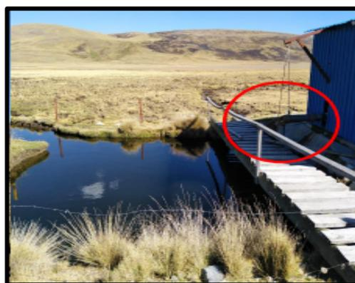
**FOTOGRAFIA N° 08 y 09** En las imágenes se aprecia el riachuelo conduciendo agua a la poza de almacenamiento donde se capta el recurso hídrico para ser conducida a través de la tubería de 6" de diámetro (tubería de succión), resaltada en el círculo hasta la Planta Concentradora María Mercedes S.A.C.
