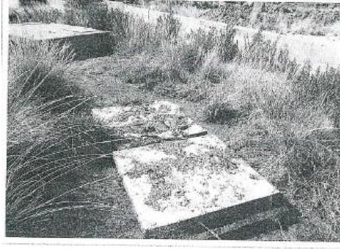
Foto N° 2 Se observa el sistema de tratamiento colapsado y en abandono
