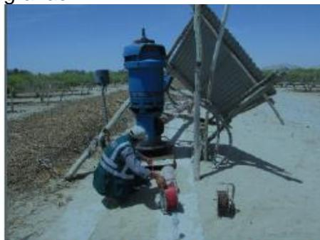
Vista del pozo con código IRHS-11-01-08-1352, el cual se encuentra con el equipo de bombeo en estado utilizado, la misma que el personal técnico del ALA RIO SECO, viene anotando las características del pozo, como así mismo viene realizando el nivel dinámico del agua
